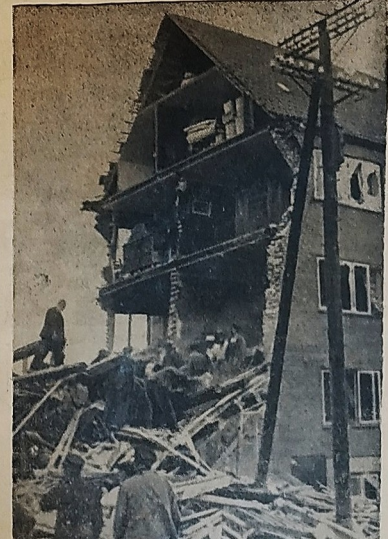
Am 5. September wurde die baltische Küstenstadt Esbjerg durch ein englisches Militärflugzeug bombardiert. Dabei wurde ein Haus zerstört (unten rechts), wobei ein Todesopfer und mehrere Verletzte zu beklagen sind.
